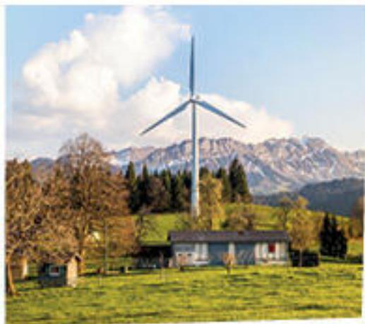
La energía eólica es inagotable y no contamina, además ocupa mucho menos espacio que un parque de celdas solares (Imagen 2.108). Sin embargo, depende de que haya viento, por lo que no se puede utilizar en cualquier lugar, sino en lugares ventosos. Por otra parte, requiere de materiales como el **neodimio**, el cual es extremadamente raro, y también puede afectar a las aves. Algunas personas consideran que también afectan el paisaje.
